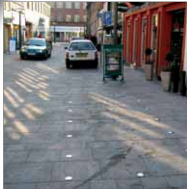
Vejsøm udlagt op til fliser i sivegade med P-båse
