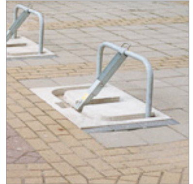
Fundament er indpasset i belægningen
