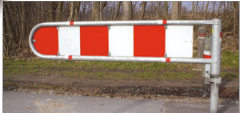
Bilspærre BG med rød/hvid baggrundsafmærkning
