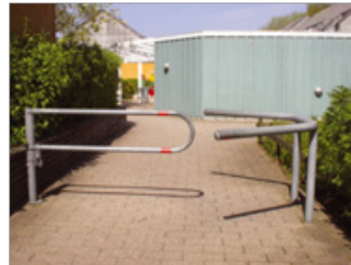
BG opstillet sammen med TF trafiksluse i B: 188 mm og Ø: 76 mm
