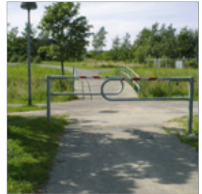
BGH beskytter ved udkørsel, når et sæt er opstillet forskudt.
