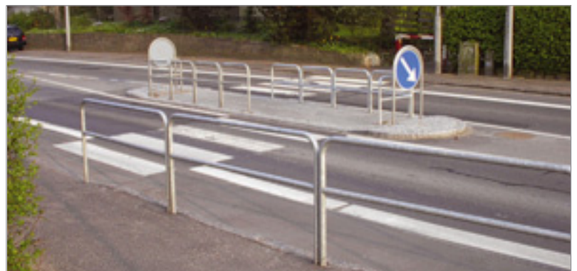
Sektionsrækværk type SR anvendt i forskudt fodgængerfelt med midtersluse
