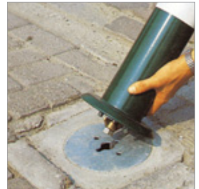
Det er nemt at montere og afmontere de flytbare Trafik steler
